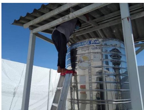
รูปที่ 15 การทำความสะอาดและตรวจสอบสภาพถังน้ำ
