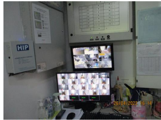
รูปที่ 19 กล้องวงจรปิด และระบบ CCTV
